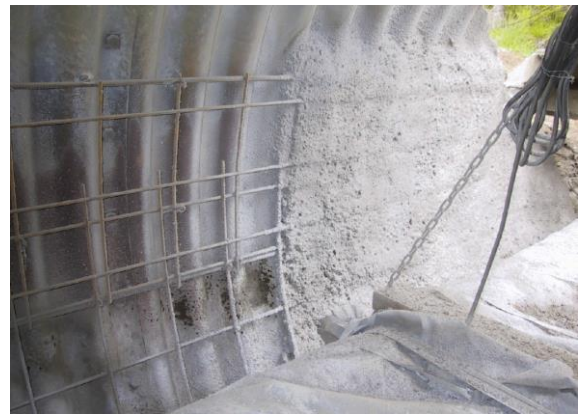
Foto 16. Truubi alaosa renoveerimine pritsbetooniga [45]
