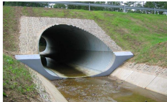
Foto 8. Kiviplokkidega kindlustamine (foto: Gediminas Viršilas [29])
