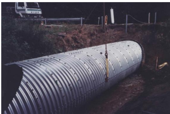
Foto 19. Uue toru asetamine vana toru sisse [45]
