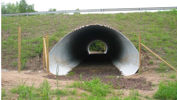
Foto 2. Muruga kindlustamine (foto: Gediminas Viršilas [29])
